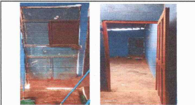
Foto 3: Estado actual que evidencia el mal estado de las puertas y la sustitución de algunas de madera.
